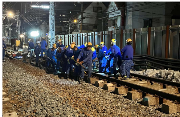
仮上り線(2回目)切替工事状況
