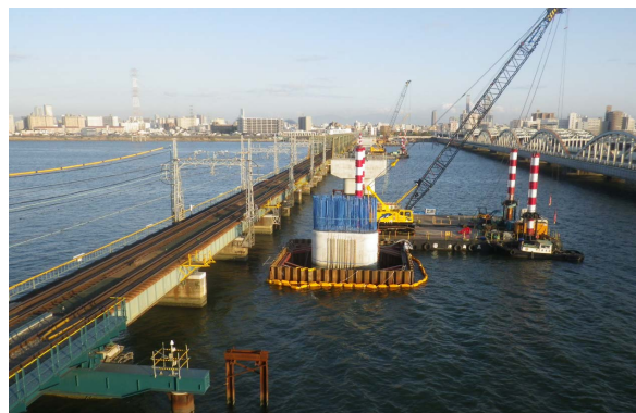
橋脚設置状況(淀川西方から)
