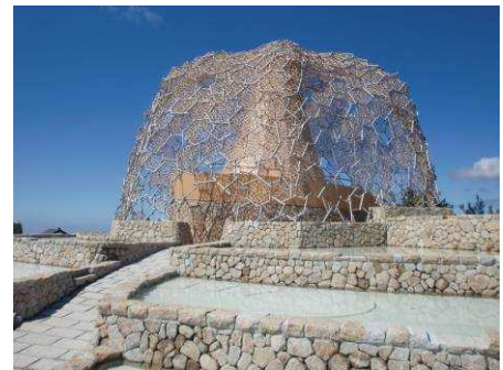
「自然体感展望台 六甲枝垂れ」外観 展望台の周りには氷棚(棚田をイメージして作られた雨水を溜める場所)があり、冬季は自然に凍った氷を採取する
