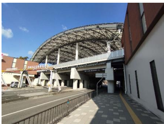
阪神本線甲子園駅 外観
