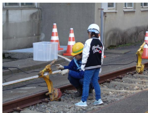
< 道床つき固め体験（前回の様子） >
