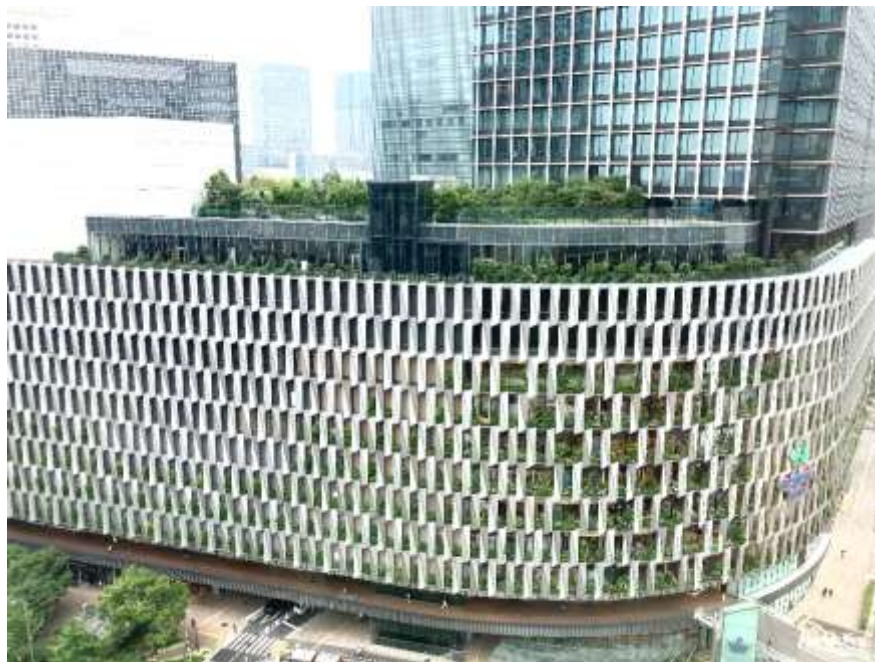
大阪梅田ツインタワーズ・サウス 壁面・屋上広場の緑化の様子
