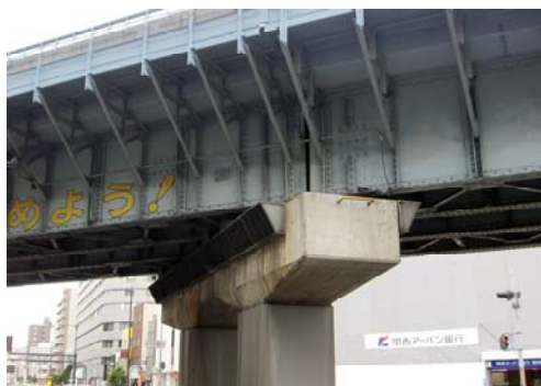
【桁受け部拡幅工法】
