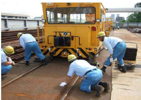
【重トロリー脱線復旧訓練】
