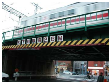
【橋桁防護工(桁)】
