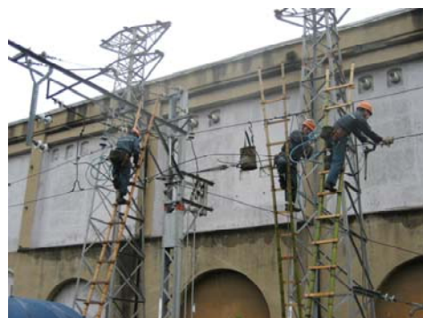
【電車線断線復旧訓練】
