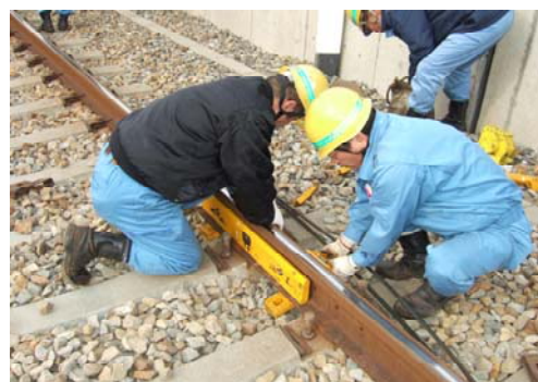
【レール折損事故応急復旧訓練】
