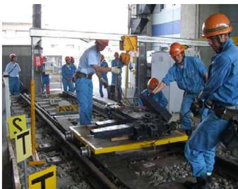
【信号設備障害復旧訓練・転てつ機交換】
