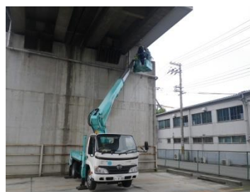
近傍での詳細目視検査
