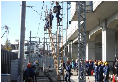
断線復旧訓練
