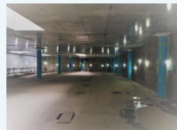
躯体構築状況
