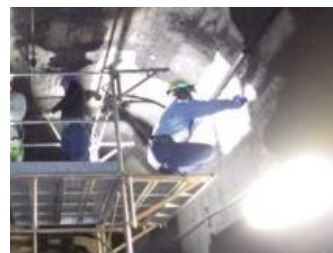
打音検査状況
