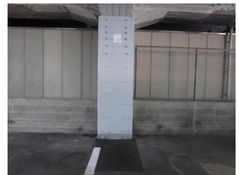
一面せん断補強工法
