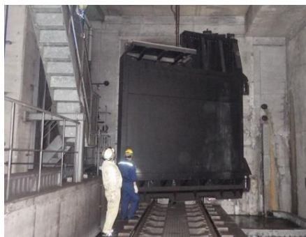
地下駅水防訓練
