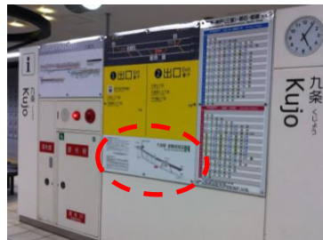
避難経路図設置状況
