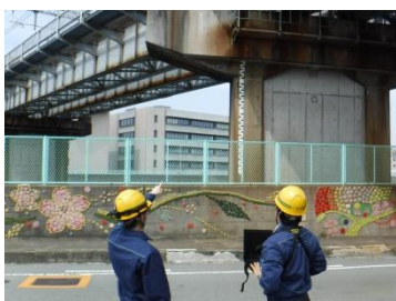
橋梁下面からの目視検査
