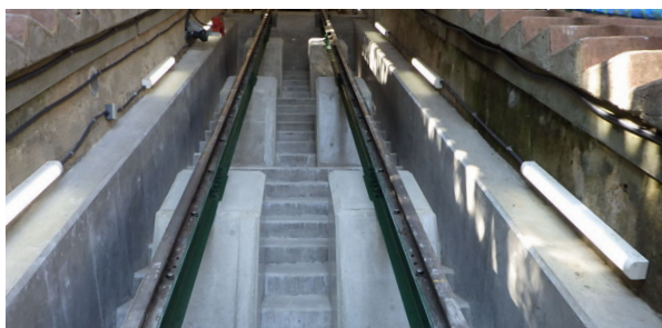
山上駅検査用ピット延伸工事
