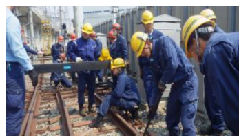
分岐レール交換合同訓練
