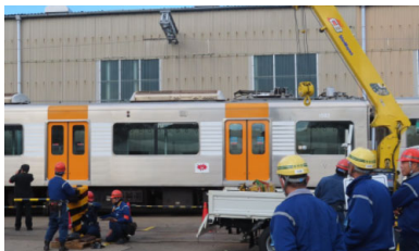
踏切遮断機復旧
