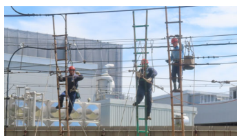
電車線断線復旧訓練
