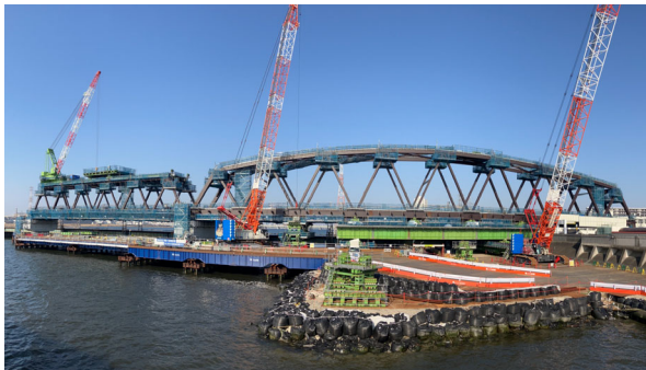
河川内の施工状況
