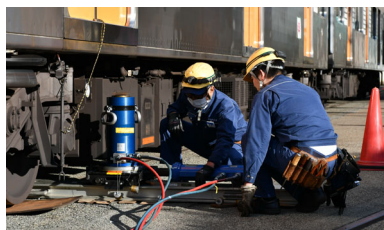
車両脱線復旧
