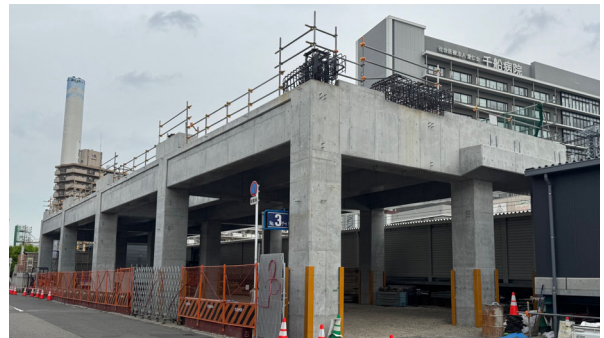
高架構造物の構築
