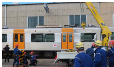
踏切遮断機復旧
