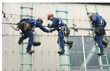
③ 電車線復旧
