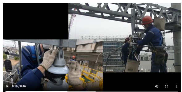
ウェアラブルカメラを用いて作成した動画教材 (電車線がいしの点検)
