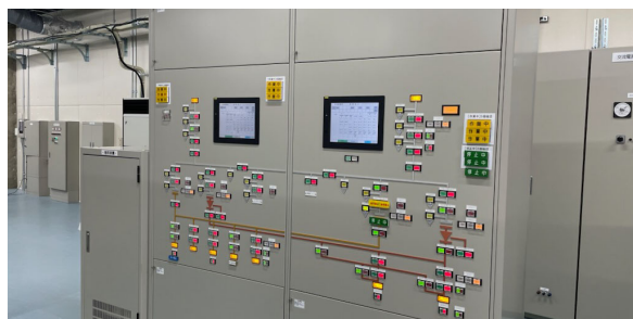
大石変電所新設
