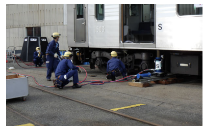
③ 車両脱線復旧
