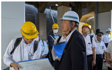
現場巡視（住吉駅バリアフリー化工事）
