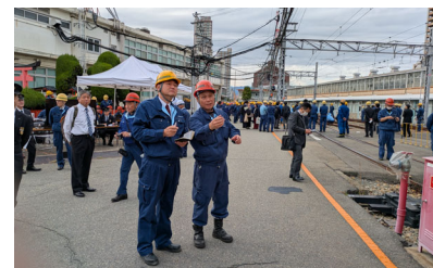
③ 社長による復旧作業確認
