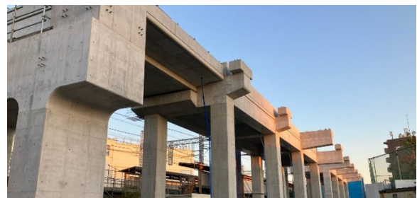
高架構造物の構築
