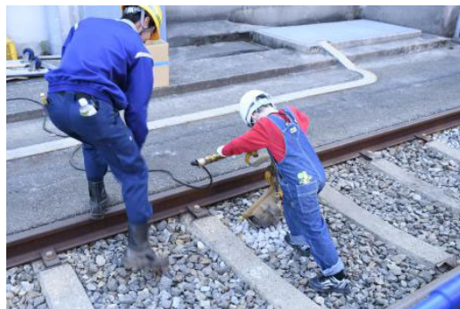
道床つき固め作業体験の様子
