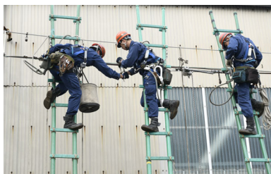
③ 電車線復旧
