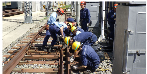
レール交換合同訓練(工務部・電気部)
