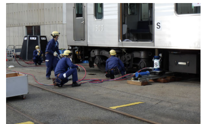
③ 車両脱線復旧
